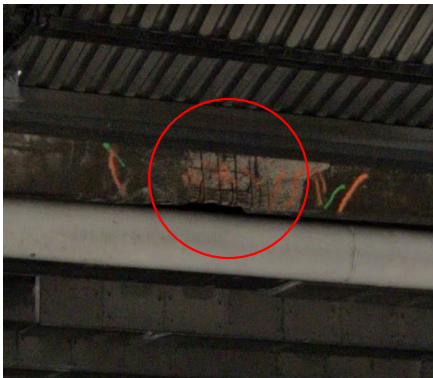
Illustration 26: Zoom des désordres sur la poutre du tunnel (Image issue de Google Maps)
