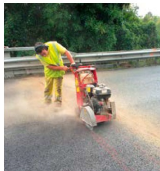
Illustration 57 : Sciage, découpage des couches de la chaussée et dégagement de la feuillure
