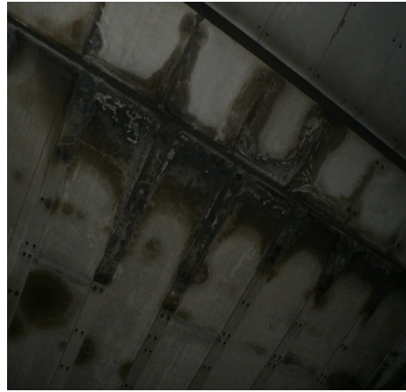
Illustration 34 Traces d'eau en plafond au niveau des joints transversaux.
