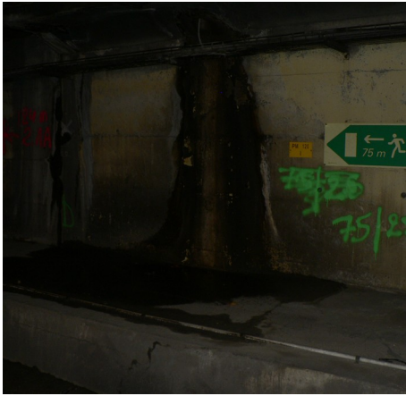
Illustration 33 Venues d'eau en piédroit dans la tranchée couverte.
