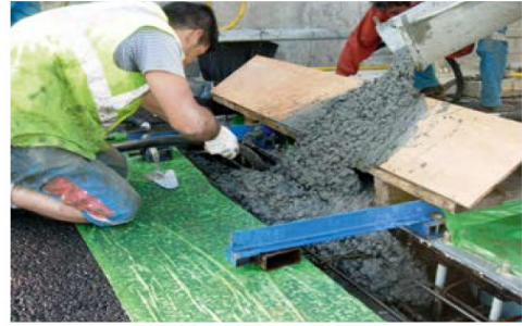
Illustration 59 : Calage des ancrages, réglage du joint par rapport au revêtement adjacent et bétonnage
