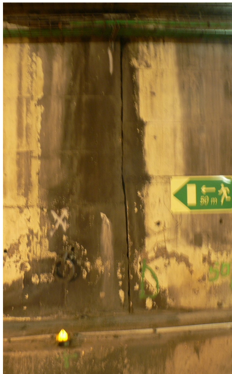
Illustration 29 Trace d'une infiltration d'eau à la jonction de deux plots béton.
