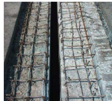
Illustration 57 : Sciage, découpage des couches de la chaussée et dégagement de la feuillure
