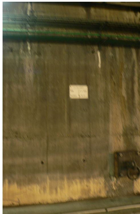
Illustration 28 Traces et phénomènes d'infiltration en tête de piédroit.
