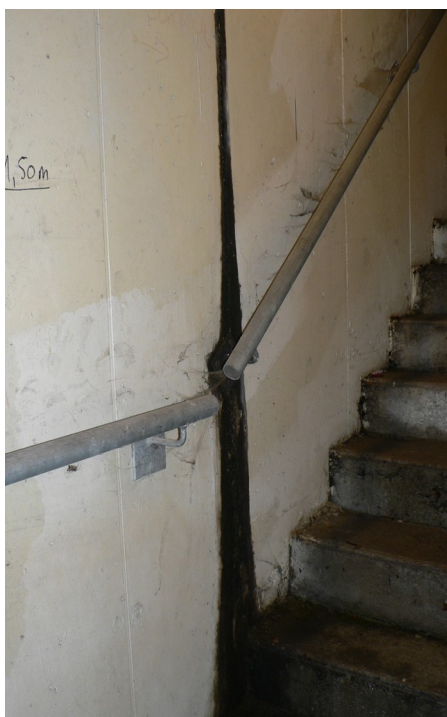
Illustration 31 Traces d'eau significatives au niveau de l'escalier d'une issue de secours.
